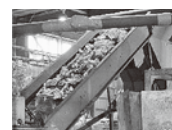
破砕機へ投入
